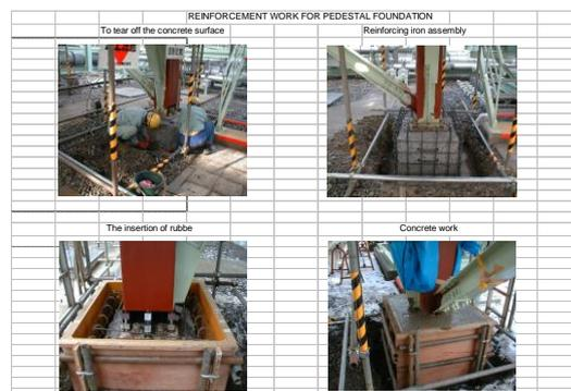
図一7 耐震補強工事（ペDESTAL基礎）
