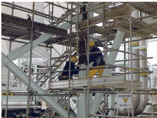
図一6 耐震補強工事（柱・梁）
